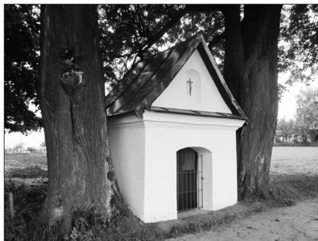
□ Kaple Dolní Rokytnice – po rekonstrukci - červenec 2017
