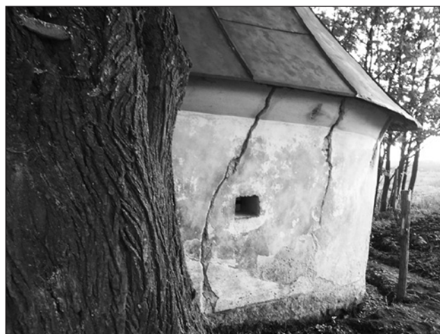
□ Kaple Dolní Rokytnice – před rekonstrukcí 2017
