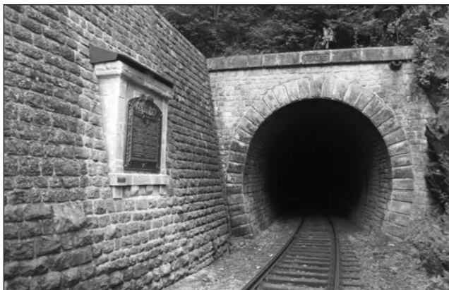
□ Nová deska opět zdobí prostor u portálu tunelu v Pěčíně.
