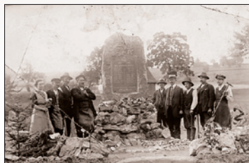
Stavba válečných pomníků v sobě nesla úctu k zemřelým občanům a spoluobojovníkům zejména ve „Velké válce“, jak se tehdy 1. světové válce říkalo. Na snímku budování pomníku padlým z Horní Rokytnice na Severádu.
