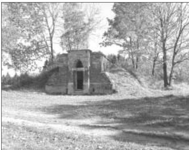
□ Současný stav okolo objektu staré vodárny.
