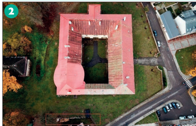
❑ Letecký snímek areálu zámku s vyznačením opravovaného úseku ohradní zdi a střechy
