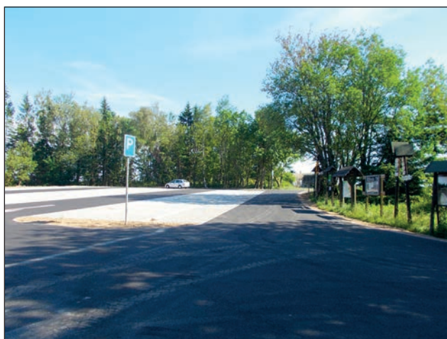
☐ Stavba záchytného parkoviště na Panském Poli, foto: D. Divíšek
