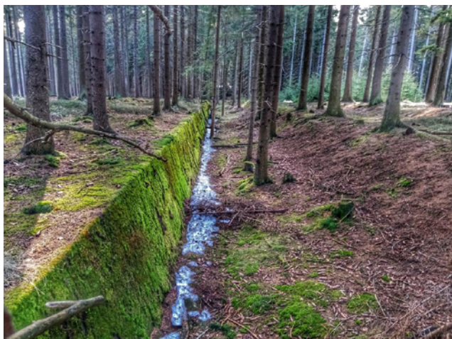
☐ Zachovalý protitankový příkop v Žamberských lesích nedaleko Bartošovic na Jiráskově stezce Foto: Marek S.
