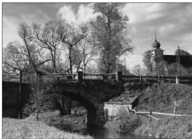
□ Hraniční most Orlické Záhoří - Mostowice.
