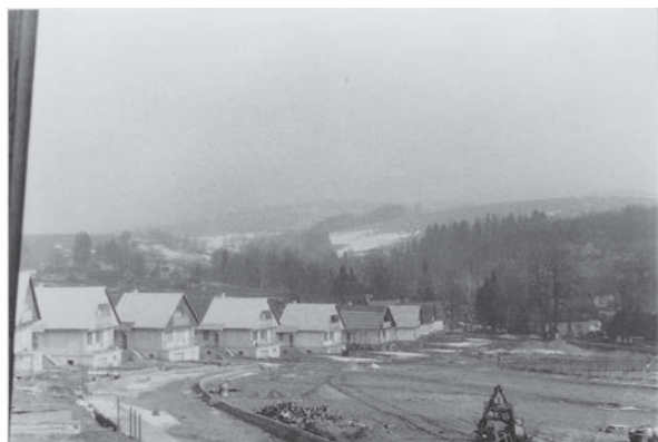
Výstavba rodinných domků Severní ulice cca 1979-1980
