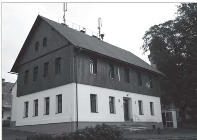
□ Opravená budova Obecního úřadu v Říčkách.
