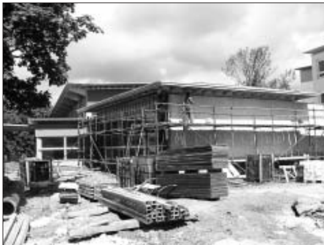
□ Celkový snímek staveniště sportovní části.
