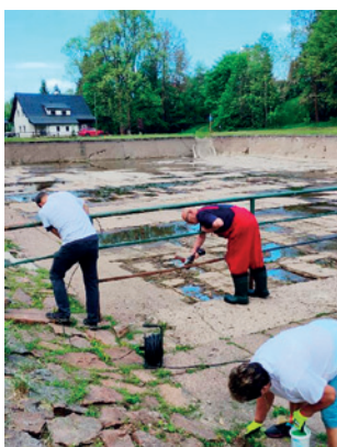
☐ Broušení a nátěr kovových prvků. Všechny kovové části zábradlí v nádrži i na mostku přes Rokytenu byly obroušeny a následně natřeny.
