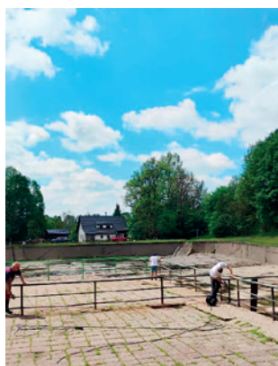
☐ Broušení a nátěr kovových prvků. Všechny kovové části zábradlí v nádrži i na mostku přes Rokytenu byly obroušeny a následně natřeny.
