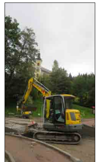
Přístup do Neratova se změnil v jedno velké staveniště
